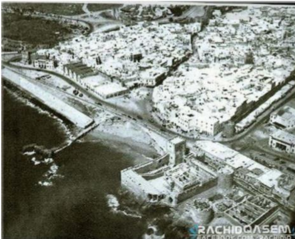
Photo 2 : Situation après l'écroulement de 1937
